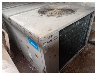
Unidad Paquete (Después del Mantenimiento)
