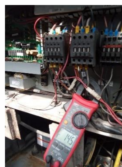
Toma de parámetros de funcionamiento (Durante el Mantenimiento)
